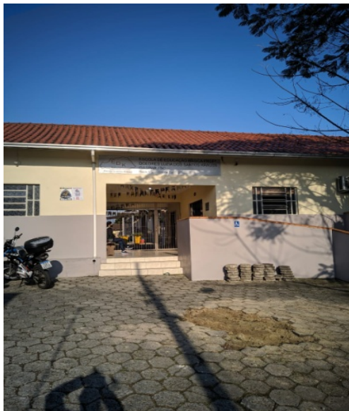
A05: EEB Professora Dolores Luzia dos Santos Krauss, Rua Guilherme Sabel, 350 – Bairro Figueira. COORDENADAS: -26.9158, -48.98438 Fonte: Proteção e Defesa Civil, 2021.
