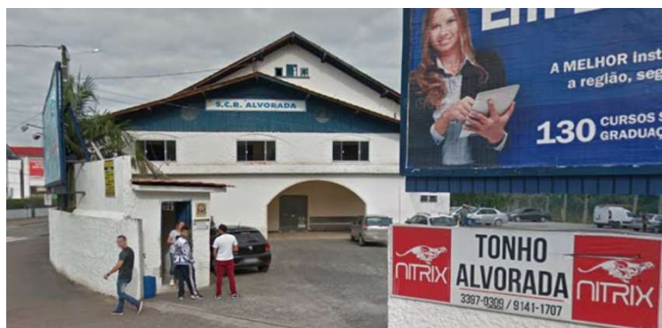
A23: Clube Alvorada (Abrigo Equipes de Resposta) Rua Coronel Aristiliano Ramos 72 – Bairro Centro COORDENADAS: -26.92728, -48.95275
