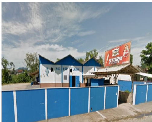
A06: Sociedade Esportiva União, Rua Luiz Franzoi, 2111 – Bairro Margem Esquerda. COORDENADAS: -26.91818, -48.97204 Fonte: Proteção e Defesa Civil, 2021.
