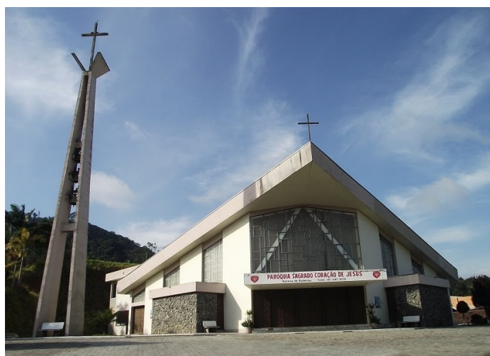
A19: Capela Sagrado Coração de Jesus, Rua Bonifácio Haendchen 4440 – Bairro Belchior COORDENADAS: -26.82714, -49.02956 Fonte: Proteção e Defesa Civil, 2021.
