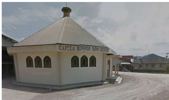
A14: Comunidades Senhor Bom Jesus, Rua Artur Poffo 01 – Bairro Santa Terezinha. COORDENADAS: -26.94399, -48.92633 Fonte: Proteção e Defesa Civil, 2021.
