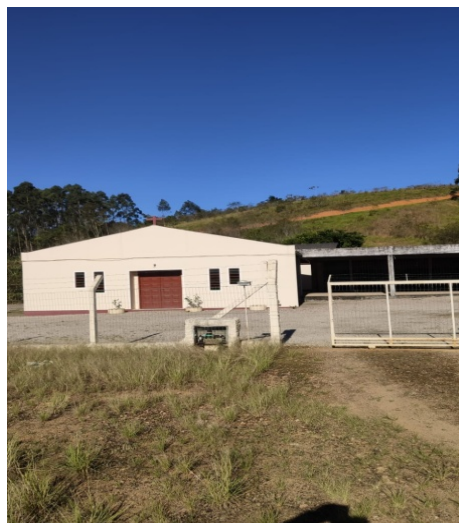
A13: Comunidades Jesus Cristo Libertador, Rodovia Jorge Lacerda s/nº - Bairro Pocinho. COORDENADAS: -26.91131, -48.8588 Fonte: Proteção e Defesa Civil, 2021.
