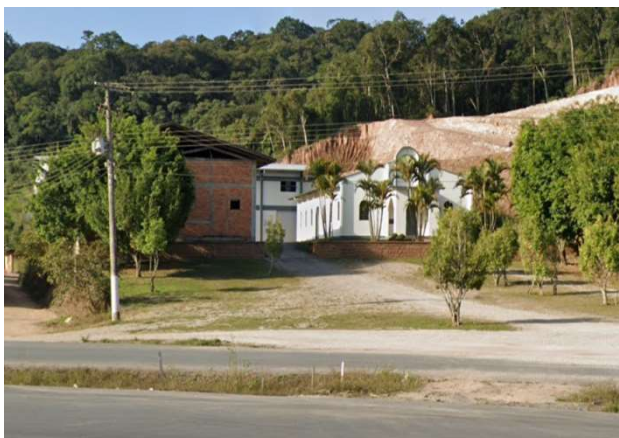
A03: Comunidade São Sebastião, Rod. BR 470 – Km 39.
